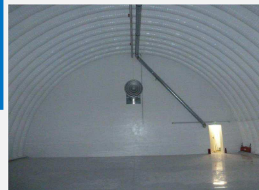
Figure 16 : vues extérieure et intérieure d'une hangarette
