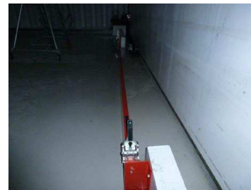
Figure 37 : barrière étanche amovible mise en place au niveau de la porte d'accès principale de la hangarette 0086 (HG7) [photo ESID]
